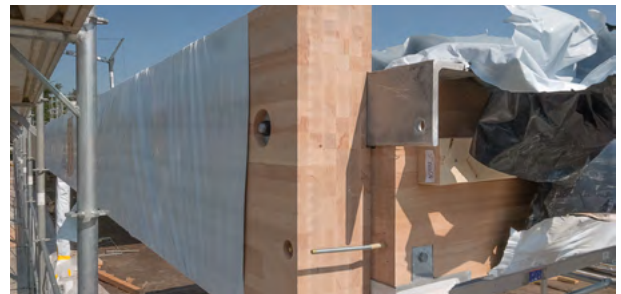
Träger aus Stabbuche bei der Montage, hier eine Aufstockung der Aligro in Chavannes/VD
