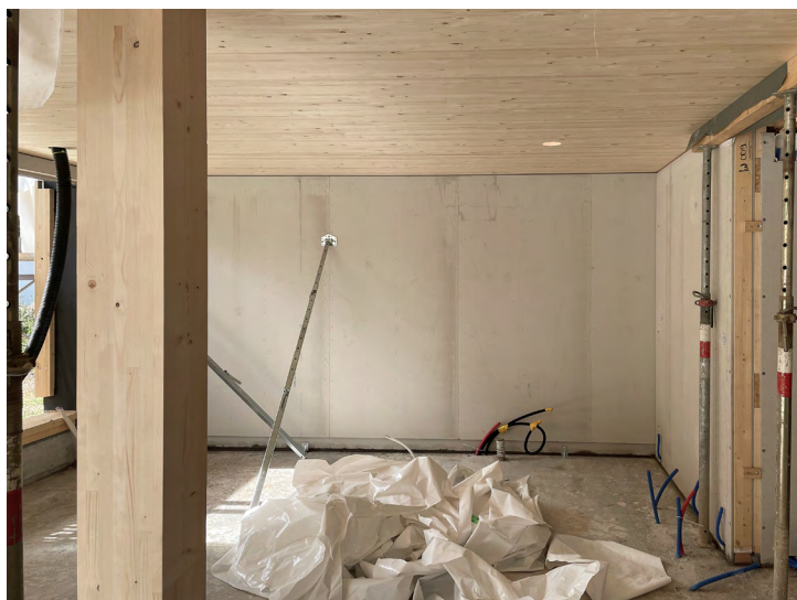
Nur an den Decken der neuen Wohnungen ist erkennbar, dass es sich um einen Holzbau handelt.
