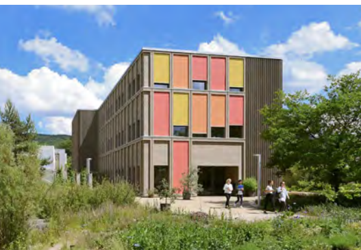
Ein Leuchtturmprojekt zum Bauen mit regionalem Holz ist der Weleda-Neubau in Arlesheim.
