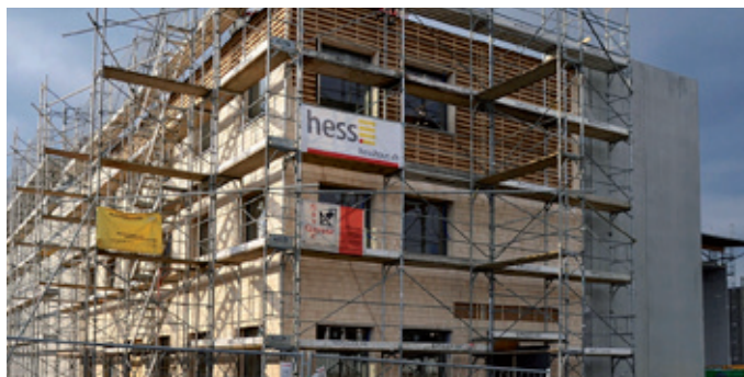
Fassade aus Weisstannenschindeln im Aufbau. Foto Ariane Tamm
