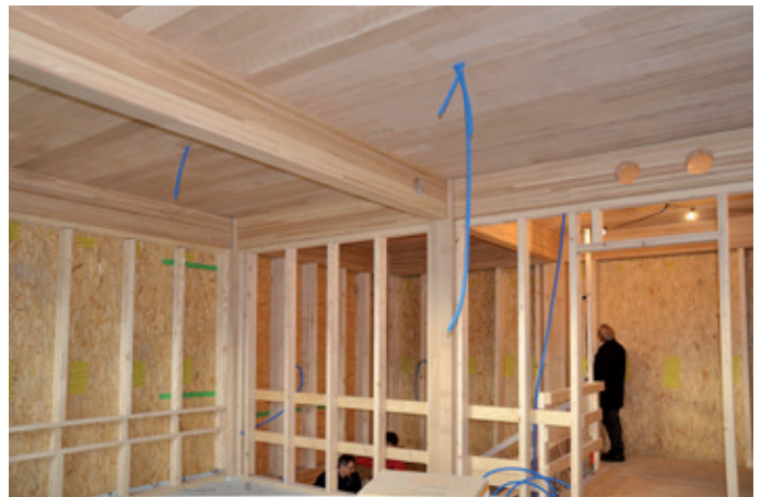
Buchenholz kommt auch beim Innenausbau der Büros zum Einsatz.
