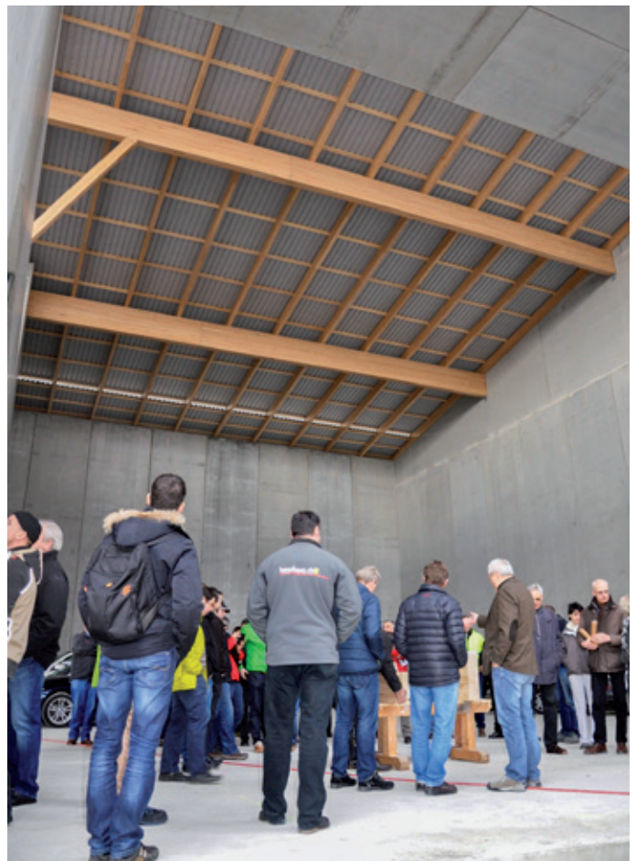
Tragende Teile des Daches aus Buchenholz, in optimaler funktioneller Kombination mit dem Baustoff Beton. Fotos Ariane Tamm
