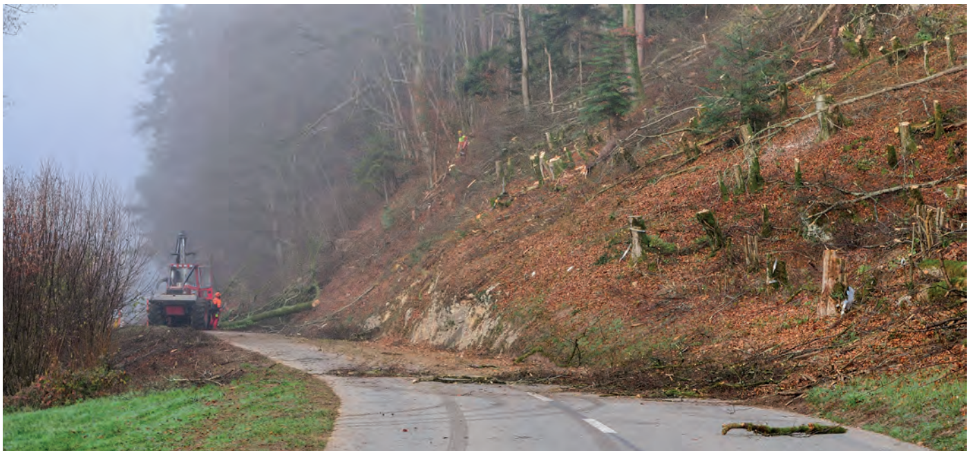
Schutzwaldpflege im Revier Laufental-Thierstein: Hohe Stöcke und quer gefälltes Holz dienen als Steinschlagschutzverbau. Foto Tom Oesch
