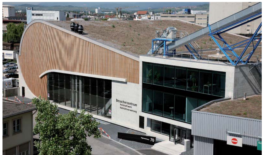
Blick auf Anlieferhalle mit der Holzfassade und dem Besucherzentrum des Holzkraftwerkes Basel.
