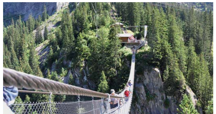
Nervenkitzel pur beim Überqueren der Hängebrücke beim Handeckfall
